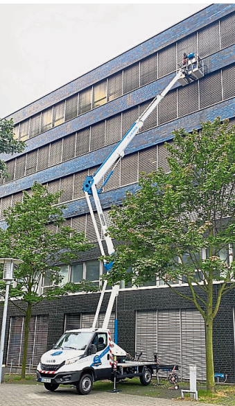
Mit dieser LKW-Gelenkarbeitsbühne geht es hinauf bis in 24 Meter Höhe.
